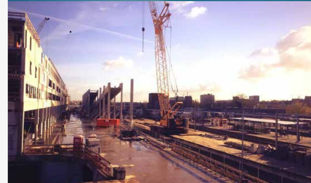
Foto boven: artist impression van de OV terminal, een ontwerp van architect Koen van Velsen Foto onder: de terminal in aanbouw, foto van november 2013
